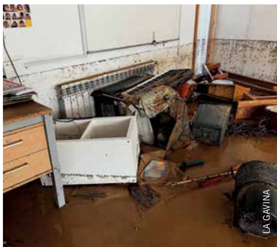
Estat de l'aula de música després de la DANA.
