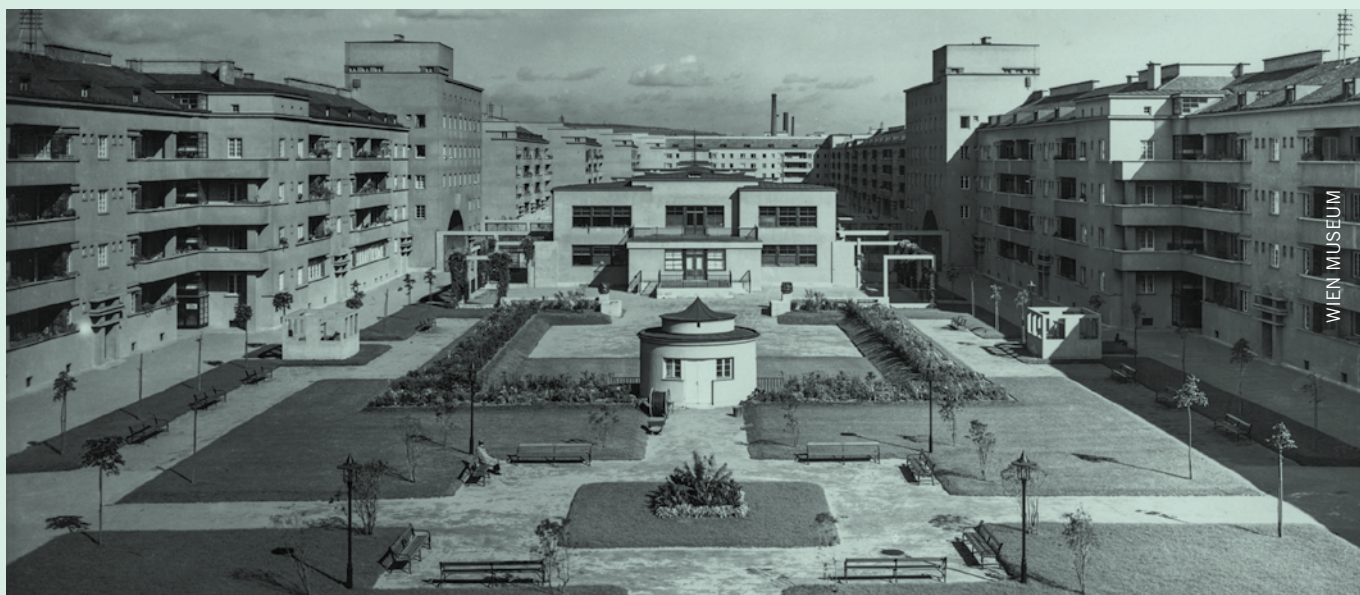
Pati interior d'illa del conjunt d'habitatges socials «Karl Marx Hof» construït durant la Viena Roja.
