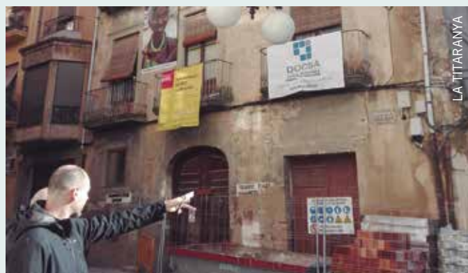
Inici de la primera fase d'obres i rehabilitació de Ca Robusté a Valls.
