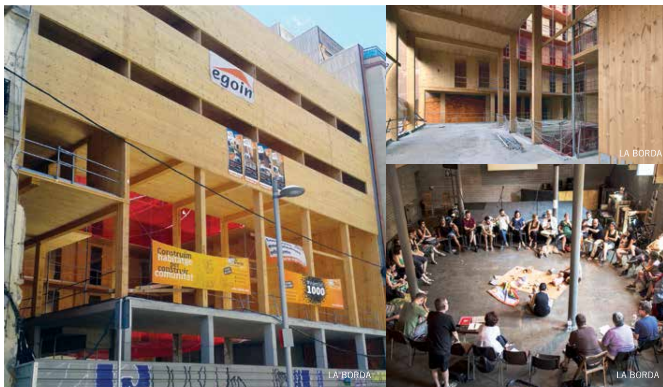
Procés de construcció de la Borda, i assemblea de sòcies també de la Borda.
