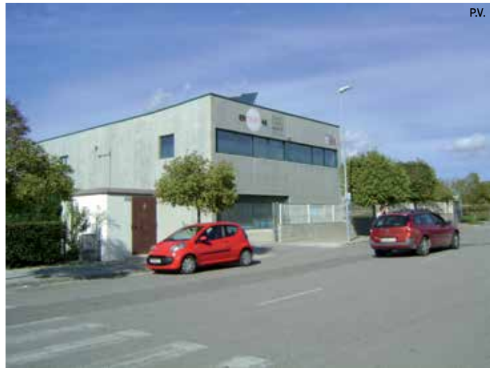
Edifici compartit per Nou Verd, amb Nou Set i Entrem-hi.
