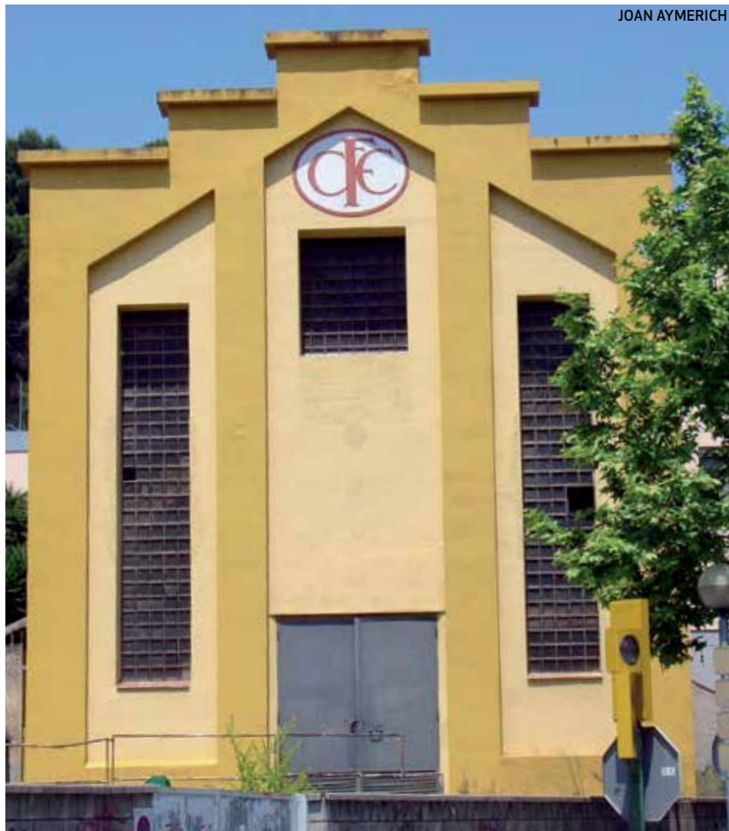
Central transformadora de Cooperativa de Fluido Eléctrico SA (CFE) a Mataró.
